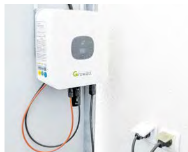
▲ Wechselhaft. Durch den Wechselrichter kommt der Solarstrom in die Steckdose.
